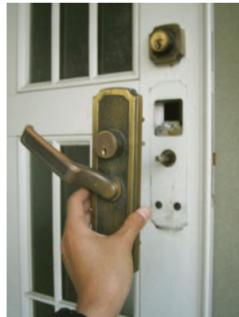
18.取外した室外側ハンドル部です。赤い矢印の先にあるネジをマイナスドライバーなどで回して、カバーからシリンダー本体を抜き取りましょう。※他のネジなどは外さないで下さい。
