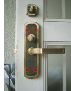
15.ドライバーを使ってネジを緩め取り外します。
