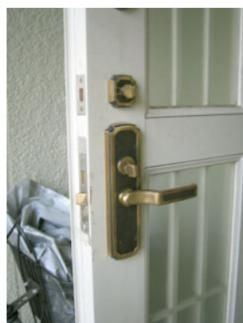
8. 上部シリンダーの補助錠部分はネジ2本がございますので、プラスドライバーを使いネジを緩め取り外します。
