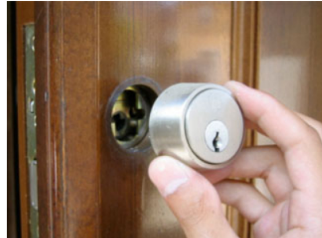
17.ピンを引き抜けば、室外側のシリンダーが取り外せます。
