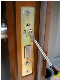
17.ピンを引き抜けば、室外側のシリンダーが取り外せます。
