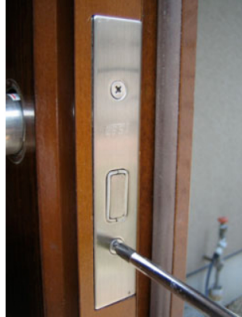
13.次に錠フロントのネジ2本を外します。
