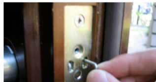
22.手順16で抜いたピンを差込み、室外側シリンダーを固定します。後は外した時と逆の手順で取付けます。
