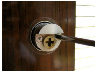
13.次に錠フロントのネジ2本を外します。
