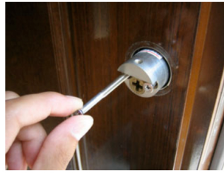
14.表面のプレートが外れます。
