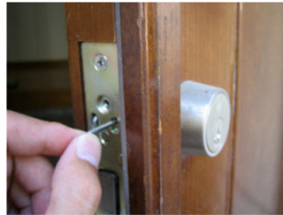
16.ピンが浮いたら、後は手で抜くことが出来ます。抜きにくい場合はペンチ等の工具を使うと簡単に引き抜けます。この際ピンを取り外すと同時に外側シリンダーも外れますので手でシリンダーを押さえながら作業して下さい。シリンダーが落下しキズがつく恐れがあります。
