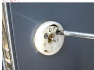
10. ネジをはずせばサムターン部のプレートが外れます。
