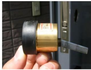
16.手順15で確認した向きにあわせて新しいシリンダーを取付ます。手順13で外したカバーを取り付けてから差し込んで下さい。
