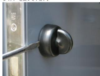
21.サムターンを外して出てきた内部のネジをプラスドライバーを使って締め外しましょう。
