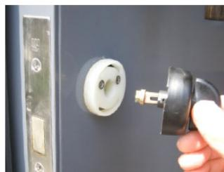
22.ネジをはずせばサムターン部のプレートが外れます。
