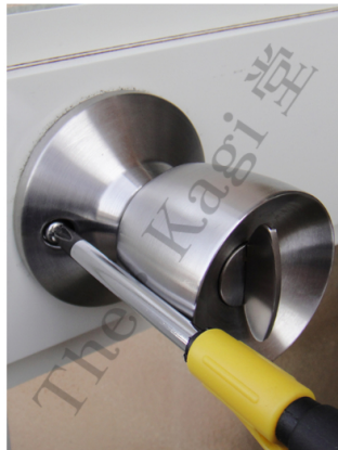
5. 室外のノブが落下しないように支えながら作業を行って下さい。
