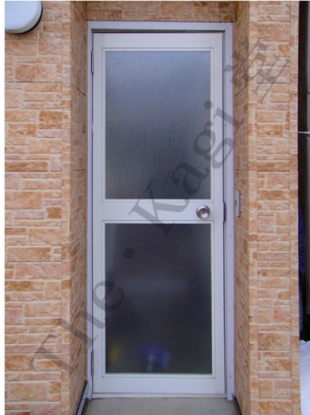
1. TOSTEM製の勝手ロドア「ロンカラー」のドアノブを取替えます。
