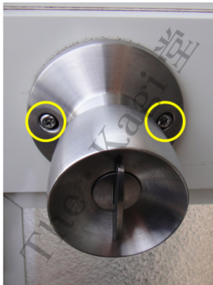
4. 室内ノブの台座にある2ヶ所の固定ネジをプラスドライバーで外します。
