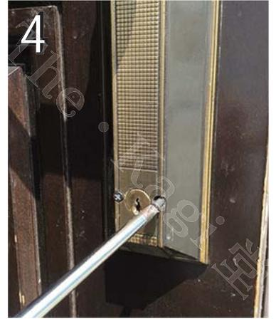
同じくハンドル下部の、室内シリンダー近くのネジ2ヶ所をプラスドライバーで外します。
