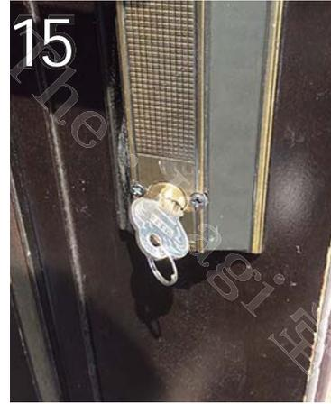
15 あとは、手順【3】～【9】を逆の流れで元に戻していきます。最後に、実際にキーで操作し、問題なく施解錠が行えるか確認して作業完了です。
