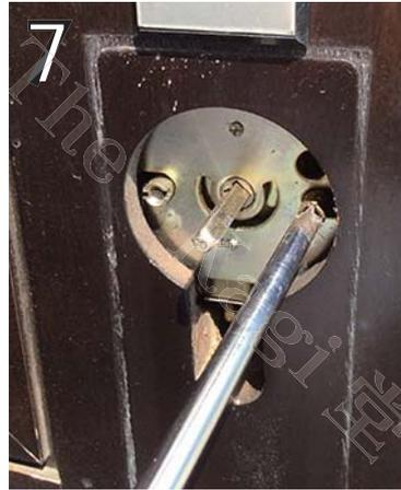
この右側の引き足で、室外側ハンドルが固定されていますので、プラスドライバーで外します。
