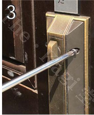
まずは、室内側ハンドルを外していきます。ハンドル上部の、サムターン近くのネジ2ヶ所をプラスドライバーで外します。
