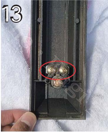
13 室内側ハンドルの下部シリンダーも、固定されている2ヶ所のネジを手順【11】【12】と同じように交換します。
