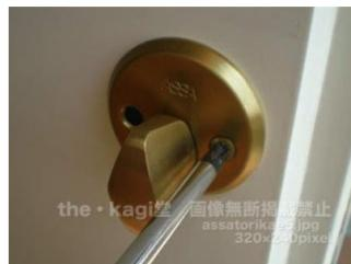
6. ビスを外しサムターンを取り外すと下記の画像の様にビスが2本見えます。これと同時に外側のシリンダーの周りにある金具もはずれます。
