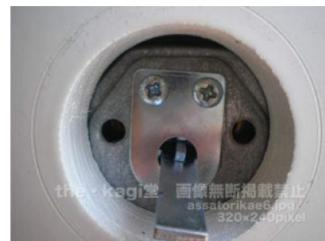
7. この2本のビスでシリンダーが固定されているのでこちらのビスを緩め取り外します。この際、外側のシリンダーが落下しないよう注意して下さい。
