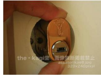
9. シリンダーをしっかり固定したら7ではずした金具とビスをしっかりと締めます。
