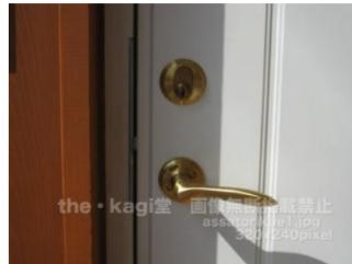
2. 小判型のシリンダーの形が特徴でシリンダーの上部分に【ASSA】と刻印されています。
