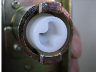
29.室内側の本体を取付けます。その際取替えたエクステンションユニットの向きを28の画像のedロック本体の向きと合うように調整します。
