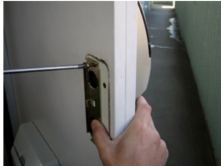
29.室内側の本体を取付けます。その際取替えたエクステンションユニットの向きを28の画像のedロック本体の向きと合うように調整します。
