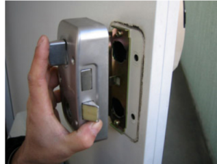
32.取り外したレバーにedロックに付属しているフランジブッシュというスペーサーを付けます。
