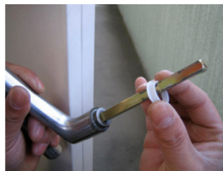
32.取り外したレバーにedロックに付属しているフランジブッシュというスペーサーを付けます。
