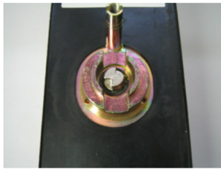
27.画像11で取り外した既存のブラケットとビス2本でedロック本体を固定します。
