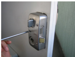
33.スペーサーをレバーに付けたらレバーを差し込みます。
