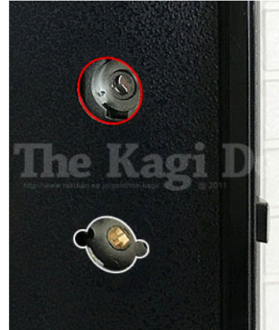
2. シリンダーとサムターン、レバーハンドルを取り除くと、それらを設置するために開けられた穴(切欠き穴)が現れます。LAタイプのedロックの取付けるには、シリンダーが取付けられていた部分の切欠き穴(赤部分)を広げる必要があります。
