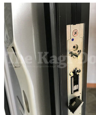
9. edロック本体の取付け完了です。
