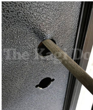
4. これをMIWA LAタイプの切欠き穴に合わせ「35mm」に半丸ヤスリ等を用いて広げていきます。
