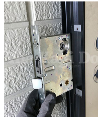
6. 次にedロック本体を取付けていきます。既存のLGKタイプの錠ケースの代わりに、MIWA LAタイプの錠ケースをドア側面から差入れます。
