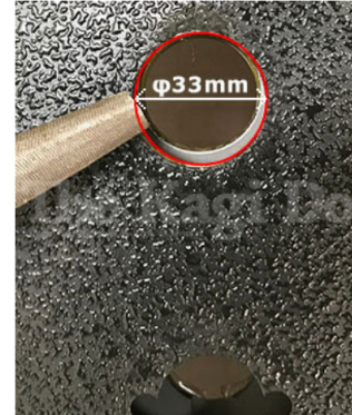
3. 図では錠ケースを外した状態の切欠き穴です。直径が「33mm」になっています。
