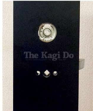
2. レバーハンドル錠をシリンダー、ハンドルを取り出した状態にしましょう。※図では、サムターンを外していますが、実際の作業では外す必要はありません。
