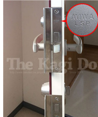
2. edロック本体と交換を行う上部シリンダーの錠前刻印は「MIWA LSP」になっているので、edロックplusは「LSPタイプ」を使用します。
