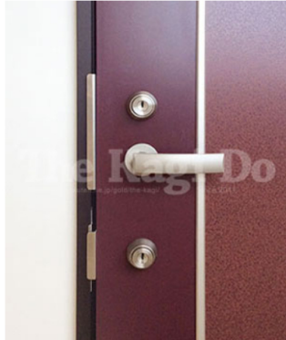
1. MIWA LSPタイプのレバーハンドル錠に、edロックPlusを取付けていきます。レバーハンドル錠の外し方は、以下リンク先を参照ください。
