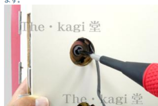
38.リーダー本体を「LAアタッチメント外」にあてがい、室内側のシリンダー穴からネジで締め付け固定します。
