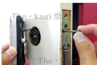
37.はめ込んだ「LAアタッチメント外」をシリンダー取付けピンで上下固定して下さい。
