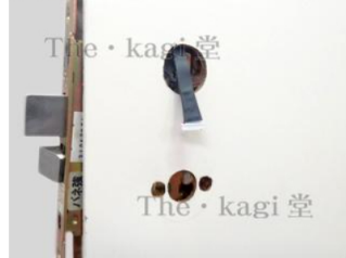
34.大抵の場合はケーブルを通し辛いので、錠ケースを外してできた隙間に配線を通し、再度錠ケースを取り付ける作業を行って下さい。
