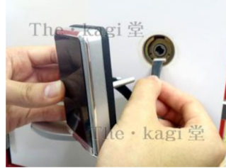
34.大抵の場合はケーブルを通し辛いので、錠ケースを外してできた隙間に配線を通し、再度錠ケースを取り付ける作業を行って下さい。
