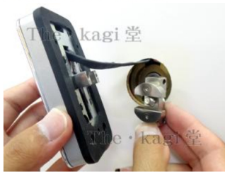
35.次に【交換手順5】で取り外した「LAアタッチメント外」を、ネジを通した状態で準備して下さい。
