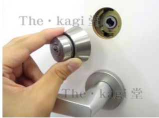
33.ケーブルを通す隙間がない場合には錠ケースを外してから配線を行います。※LAハンドルセットの取り外し方法はこちらをご参照下さい。
