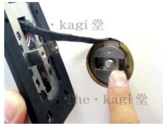
38.リーダー本体を「LAアタッチメント外」にあてがい、室内側のシリンダー穴からネジで締め付け固定します。
