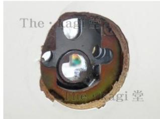
36.大抵の場合はケーブルを通し辛いので、錠ケースを外してできた隙間に配線を通し、再度錠ケースを取り付ける作業を行って下さい。
