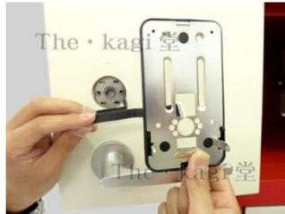
40.赤丸部分を錠ケースのネジ用貫通穴に合わせながらドアに密着させます。
