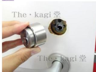
34.室外側からドアと錠ケースの隙間にリーダー本体裏のケーブルを通します。ケーブルを無理に引っ張ったり、切断・破損しないように慎重に作業して下さい。
