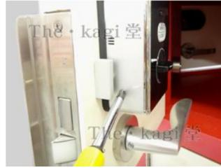
56.さらに「M3×5 特皿ネジ」で電池ケース奥の赤丸部分を留め付けて下さい。
