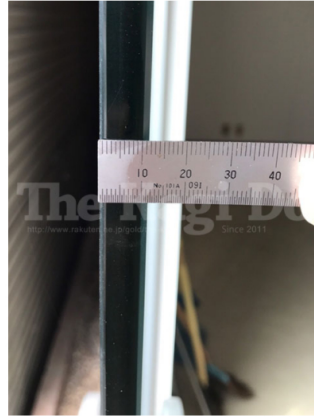
2. まずは、既存のガラス厚をスケール等で測ります。本製品が「12mm」専用のため、必ず確認しましょう。
