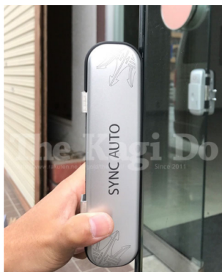
4. 次に、錠本体を設置していきます。ガラス扉側面から錠本体の溝にスライドさせながら設置します。
