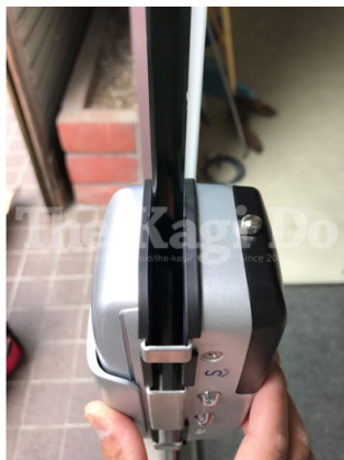
4. 次に、錠本体を設置していきます。ガラス扉側面から錠本体の溝にスライドさせながら設置します。
