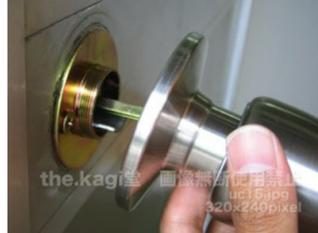
16.ある程度ロースを回しましたらドアノブの付け根あたりに直径2mm程の小さな穴がありますのでそこに専用スバチを引っかけてしっかり締めます。
