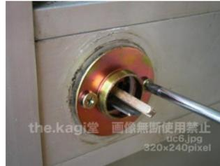
7. ネジを外しプレートを外すと外側のノブも外れますので引き抜きましょう。
