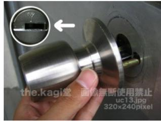
14.次に12.で取り外したプレートを付属のビスで取付けます。閉め過ぎにご注意下さい。
