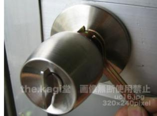
17.室内側のサムターン・キーを差し込み動作を確認します。これで取替完了です。約15~20分程で取替できます。
