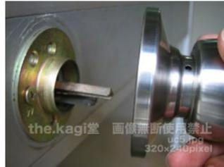
6. すると2本のビスで止めているプレートがありますのでビスをドライバーで取り外します。この時室外側のノブが落下しないよう注意しましょう。
