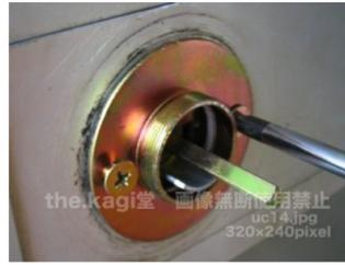
15.本体室内側(サムターン)を取付けます。8.のスピンドルの向きに注意して下さい。室内側のノブの付け根を時計回りに回していきましょう。
