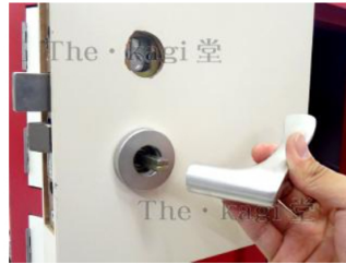
18.次にハンドルの台座を外します。台座の隙間にマイナスドライバーを引っ掛け、テコの原理で外します。怪我等には十分お気をつけ下さい。
