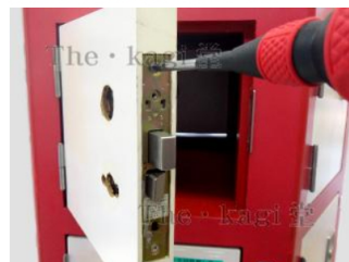
23.最後に錠ケースの固定ネジを上下2本外し、ケースを取り出せば取り外し作業は完了です。
