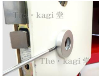
18.次にハンドルの台座を外します。台座の隙間にマイナスドライバーを引っ掛け、テコの原理で外します。怪我等には十分お気をつけ下さい。
