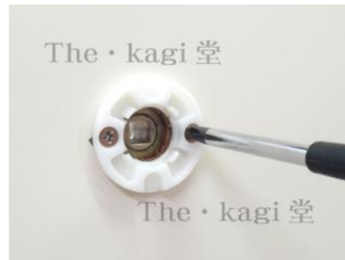
20.プラスドライバーで左右2本のネジを外します。
