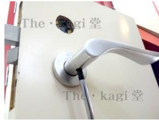
15.続いて、レバーハンドルを取り外していきます。プラスドライバーで室内側レバーハンドル裏下のネジを外して下さい。
