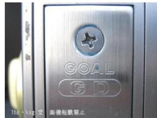
7. ネジ2本を取り外せば、シリンダーが外せます。外したシリンダーは下記画像のような形状で中心のテール(ヘッド部分)がクルクル回るタイプがADタイプの特徴です。テールが回らない固定型の場合はTXタイプになります。
