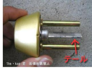
9. 取替するシリンダーを取付けます。8の画像のテールの向きに合わせてシリンダーを差し込みます。
