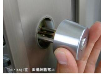
11. 次に6で取り外したサムターンを取付けます。中心のテールの向きを穴に合うように確認しましょう。
