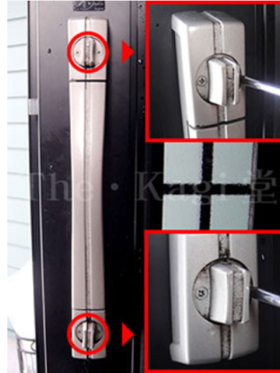
2. まずは、室内ハンドルから外していきます。室内サムターン計4ヶ所の固定ネジをプラスドライバーで外します。※室内外のハンドルが落ちないように支えながら作業を行って下さい。
