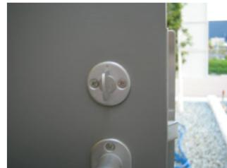
6.このネジ2本をプラスドライバーで緩め取り外します。ビス2本を外すと同時にシリンダーも外れますので、外側シリンダーが落しないよう手で持ちながら作業をしましょう。
