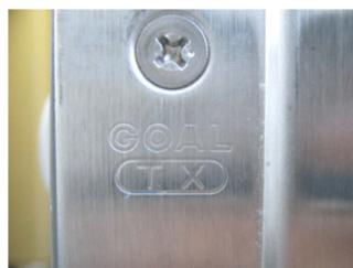
5.室内側のサムターン部分を見てみましょう。ネジ2本でシリンダーとサムターンが固定されています。
