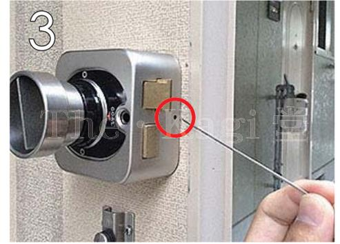
3 室内側本体の側面に、直径 2mm (ほどの) 穴があります。ここに金属製の長い棒 (六角レンチ等) を挿し入れます。
