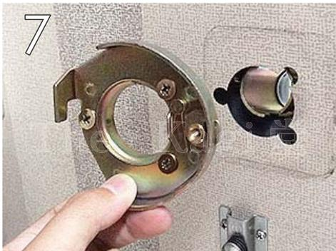
7 本体ごと交換する場合は、図の台座もドライバーで 3 ヶ所のネジを外し、取り除きます。→シリンダー交換は【手順 9】へ
