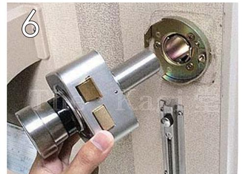
6 傾けた状態になると、図のように室内側本体を引き抜けます。
