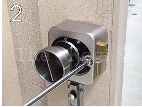
2 室内側から作業します。プラスドライバーで、箱錠本体にあるネジを 1 ヶ所外します。
