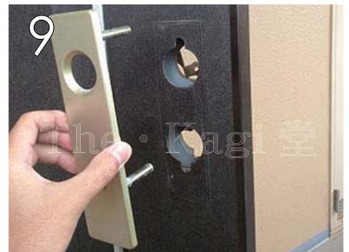
次に外側の台座も外し、逆の手順で新しいものを取り付けて、本体交換は完了です。→シリンダー交換は【手順10】へ
