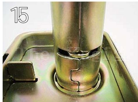
シリンダーを外した筒部の底面に溝があることを確認して下さい。ない場合は加工して溝を掘り込むか、箱錠まるごと交換になります。
