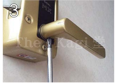
室内側レバーの付根にあるネジをプラスドライバーで外します。
