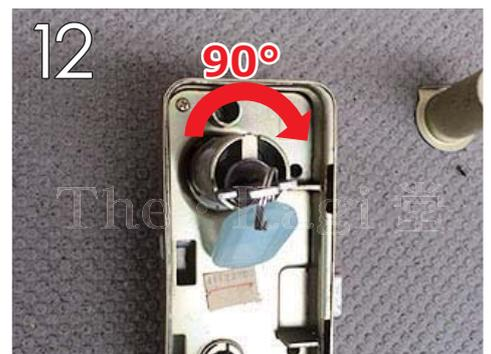
この状態で、シリンダーにキーを挿し込み、時計回りに90度回します。
