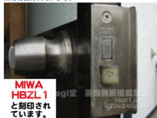
2. このタイプは室内側のドアノブの付け根あたりに約2mmの穴があります。この穴に先が細い金属棒等を刺し込むとノブが簡単に外れます。
