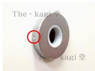
15.ネジが現れ、プラスドライバーで左右2本を外します。
