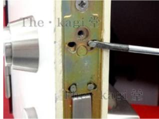
8. ピンは室外側・室内側の上下2本を引き抜くと、シリンダーとサムターンが外れますので、落とさないように押さえながら作業しましょう。
