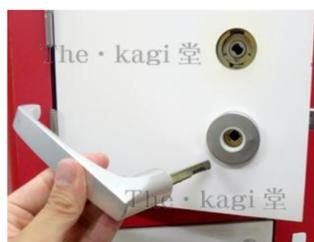
13. 次にレバーハンドルの台座を外します。室内側台座のくぼみを確認して下さい。くぼみが無い場合は【交換手順16】をご覧ください。
