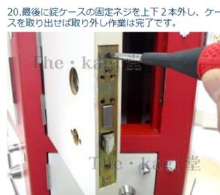
20.最後に錠ケースの固定ネジを上下2本外し、ケースを取り出せば取り外し作業は完了です。
