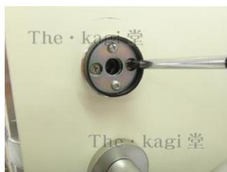
8.ネジを外す際は室外側のシリンダーを落とさないよう、片方の手で押さえながら行って下さい。
