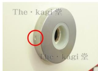
15.ネジが現れ、プラスドライバーで左右2本を外します。
