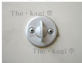
7.プラスドライバーで左右2本のネジを外します。
