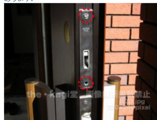
22.ビスを取ればケースも取り外す事が出来ます。取り外したら新しいケースを取付、今までの逆の作業を行いシリンダー交換をして下さい。
