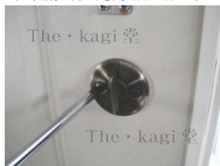
21.次に上側のシリンダーを交換します。室内側のサムターン部分のネジ2本をドライバーで外します。
