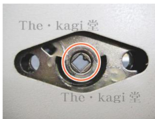
18.手順17で確認した先端を、下画像の丸印に入るように取り付けます。
