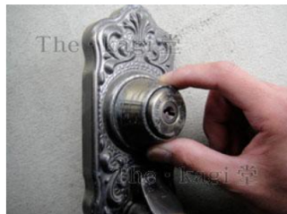
17.取り付けは基本的に今までの逆の作業ですが、13で外したプレートを取り付ける際は印の部分に注意しましょう。
