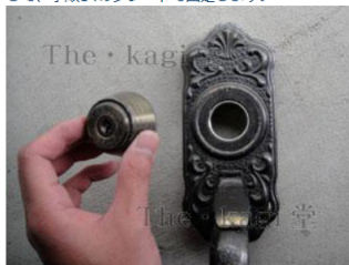
16.シリンダーが外れました。逆の手順で新しいシリンダーを取り付けます。時計回りに回し、最後まで回したらメーカーのロゴマークが上に来るように少し戻して、手順14のプレートで固定します。
