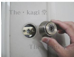
22.サムターンを取り外すと同時に外側シリンダーも取り外せます。
