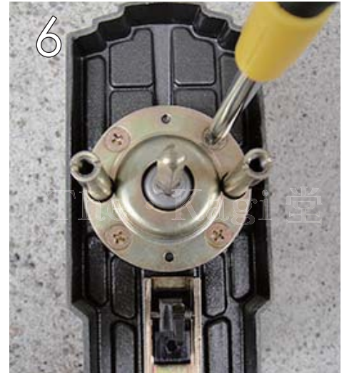
6 外した固定ネジは、新しいものを固定する時にも使用するなので、ネジ穴が滑らないように気をつけましょう。
