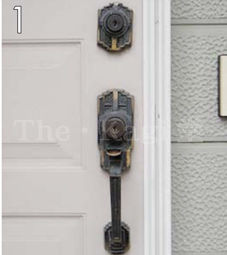
1 ツーロックの MIWA 製サムラッチハンドルの交換を行っていきます。
