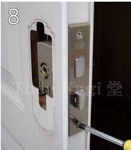
8 主錠ケースを交換する場合は、ハンドルを外した後にフロントプレートの固定ネジを外し、新しいものを入替えます。
