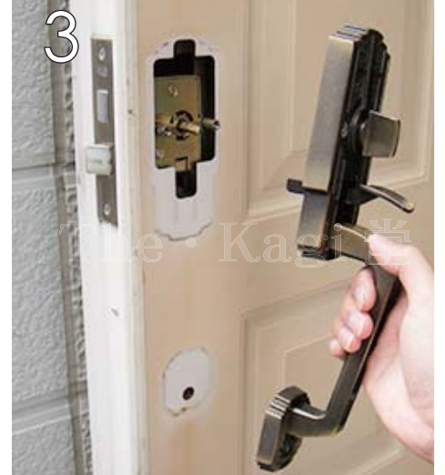
3 先程のネジが外れると、室内側ハンドルを引き抜けます。
