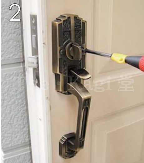
2 まずは、主錠のシリンダーを交換します。室内側ハンドルの固定ネジ3ヶ所をプラスドライバーで外します。
