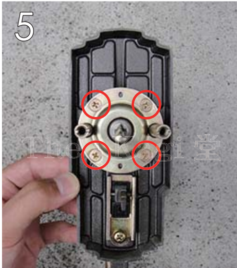
5 室外側ハンドルの裏側にシリンダーを固定しているネジが4ヶ所あるのでプラスドライバーで外します。
