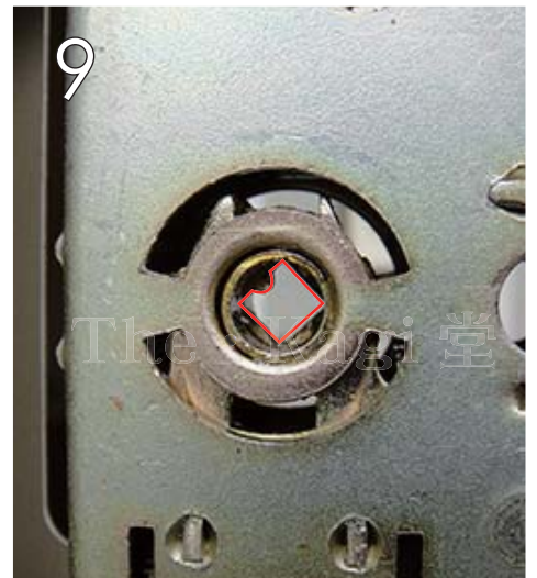
9 ハンドルを付け直す際は、主錠ケースの穴の形に合わせてシリンダーのテール部分を差し込みます。
