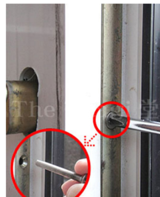
6. 室内ハンドルが引抜けます。引抜く時は、室外ハンドルが落ちない注意しましょう。
