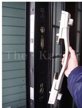
3. 室内ハンドルが外れます。※室外側のハンドルが落ちないように支えながら引き抜きましょう。
