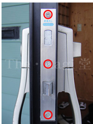
5. 錠ケース部分のみ交換する場合は、内外ハンドルを外した後に、錠ケースの固定ネジを外し、新しいものを入れ替えて下さい。
