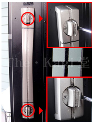
2. まずは、室内ハンドルから外していきます。室内サムターン側の計4ヶ所の固定ネジをプラスドライバーで外します。※室内外のハンドルが落ちないように支えながら作業を行って下さい。
