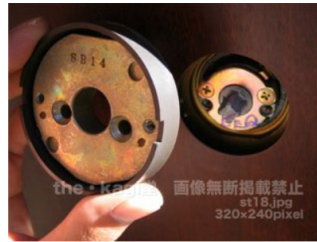
20.次はケース(機械部分)の取り外し方です。ケースも取替る方をご参照下さい。ドアを横から見てみるとメーカー等の刻印があった部分の上下に2本のビスがあります。
