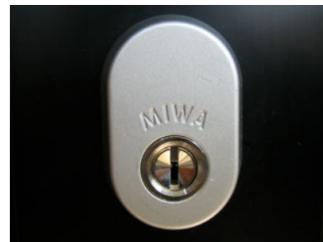
18.キーを差してスムーズに施錠・解錠出来たら取替完了です。上下2個シリンダーの取替ですが比較的簡単に取替できます。
