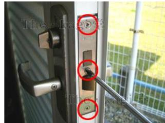
3.プレートを外したフロントです。印のついているビス1本を先程と同じように取り外します。
