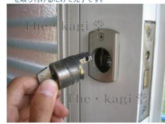
15.これで上下シリンダーの交換作業が完了です。下側の錠ケース交換の場合、手順120の緑印のビス2本も抜き取ることで交換が出来ます。
