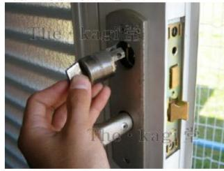
6.取り外したシリンダーです。室内外のシリンダーは錠ケース内部で画像のように組み合わさり、印の穴に手順4で外したビスが通ることで固定されています。
