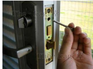
5.手順4まで終わればシリンダーが外れます。室外側と室内側、両側のシリンダーを外します。
