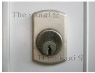
12.シリンダーのみ交換の場合は赤印のビス1本、錠ケース交換の場合は赤印と緑印のビス計3本を外します。
