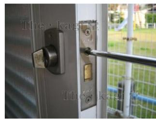
す。シリンダーのみ交換の場合、後は新しいシリンダーを取り付けるだけで完了です。
