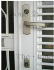
2.ハンドルがついている上側から交換します。扉を開いて側面にある、錠ケースフロントのビス3本をプラスドライバーを使って外し、プレートを外します。
