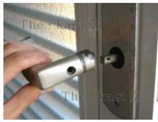
10.ここまで終われば錠ケースを抜き取れます。取り外した時とは逆の手順で、新しい錠ケースを取り付けましょう。後はシリンダーを取り付けて完了です。
