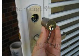
8.錠ケース交換はシリンダーを外した状態で行います。まずはレバーハンドルを外すので室内側のハンドルの根元、印のビス1本を取り外します。
