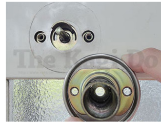
6. 室内ノブの座金を外れます。室外ノブが落ちないように注意しましょう。
