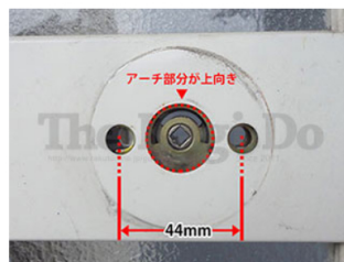
8. 図はピッチ「44mm」で、ロールバック片(半月板)は1ヶ所の「ワンスピンドル」タイプになっています。
