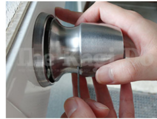
3. 既存のノブを外し、詳しい適合条件を確認しましょう。HBZタイプは室内ノブの付根にある穴に、精密ドライバーなど先端が尖った細い金属棒を差し込みながら、ノブを手前に引くと外れます。
