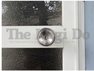
1. 旧型MIWA HBZ・HBZSPタイプの握り玉錠のノブ部分をW2-DACに交換する手順を説明していきます。
