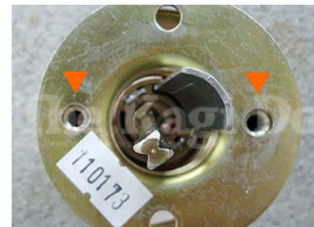
12. 室外ノブとプレートを重ねて位置の調整をしましょう。図のように取付脚が重なって見える
