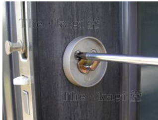
17.同時に下側のシリンダーも取り外せますので、新しいものと取り替えて固定します。これで鍵の交換は完了です。
