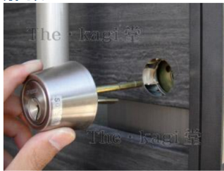
17.同時に下側のシリンダーも取り外せますので、新しいものと取り替えて固定します。これで鍵の交換は完了です。
