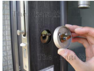
16.これで下側のサムターンが完全に取り外せます。
