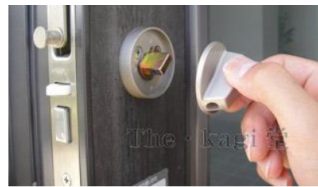
14.サムターンの中心にある金具を画像のように縦の位置にして、表面に見えるネジ2本を取り外します。 ※画像が黒色になっていますが無視して下さい。
