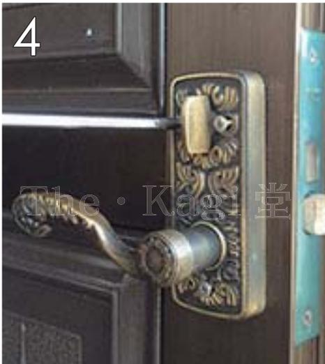
4 まずは、室内側ハンドルの固定ネジ3ヶ所をプラスドライバーで外します。
