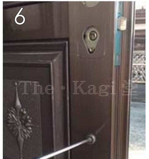
6 室内側ハンドルの下に外ハンドルを固定しているネジがあるので、プラスドライバーで外します。
