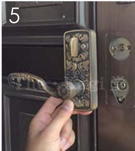
5 先程のネジが外れると、室内側ハンドルを引き抜けます。
