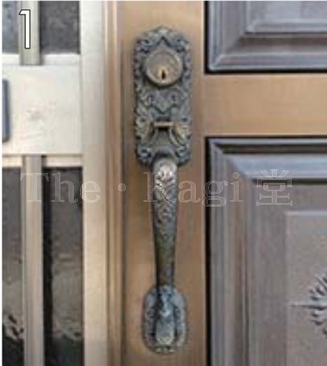
1 TOSTEM 製の玄関ドアに使用されている SHOWA 製のサムラッチハンドルの交換を行っていきます。
