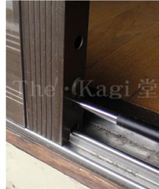
3. 引戸下部にある調整戸車の穴にドライバーなどを差し込み、回して切欠き穴の位置を調整しましょう。
