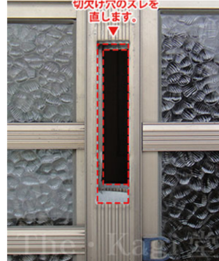
2. 既存の引戸錠を外すと切欠き穴(取付け穴)が現れます。図のように内障子と外障子の切欠き穴がズれている場合は、上手く錠が取り付けられないので調整をします。
