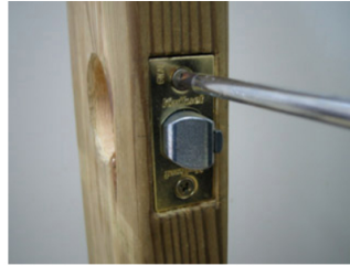
16.次にノブ本体を差し込むのですが、そのままでは差し込めないのでラッチを指で押しながら取り付けます。
