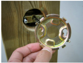
21.固定したらドライバーで2本のビスをしっかりと締めます。
