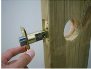
13.バックセットの確認が終わったらラッチを取付けます。
