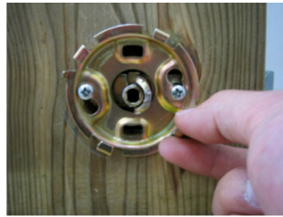
20.プレートを付けたら反時計回りに回し、ビス穴が小さい所でプレートを固定させます。
