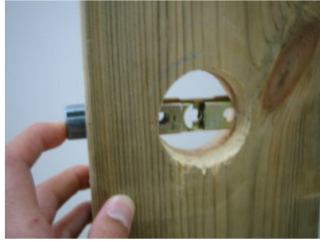
17.ラッチを16の画像のように押しながらノブ本体を差し込みます。
