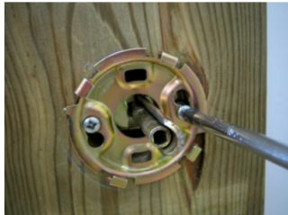
23.下記画像の様に矢印がありますので上下の矢印が揃っている事を確認します。
