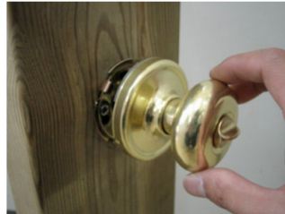
24.画像23の矢印が揃っている事を確認したらノブを差し込みます。
