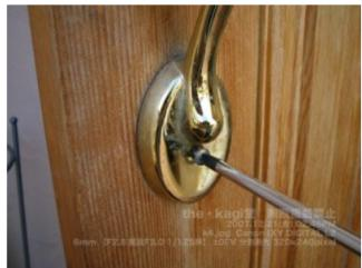
18.付属のネジでしっかりと締めます。台座にビス穴が2ヶ所開いておりますが穴が小さい方でビスを締めます。
