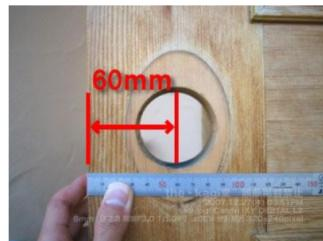
11.黒いつまみを下に下げ左右に移動することでより60mmが70mmに変更できます。この場合は9で測ったバックセットが
