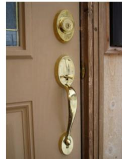
29.デットボルト・ラッチのストライク(受側)のバーツも付属されていますので必要に応じて取替しましょう。
