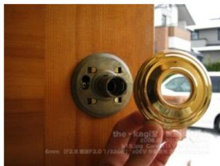
21.次にレバーを取り付けます。取り付けた台座にはめ込みます。
