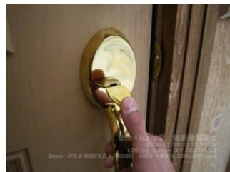
27.次にハンドル上部のシリンダー部分の取替をします。取替方法は[こちら](#)のKwiksetシリンダー取替方法をご参照下さい。基本的にシリンダー交換の作業です。
