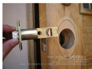
9.次に既存のバックセットを確認します。ドアの端から切り欠き(円の穴)の中心の長さを測ります。この場合は60mmです。TITAN・Kwiksetの場合60mmか70mmになります。
