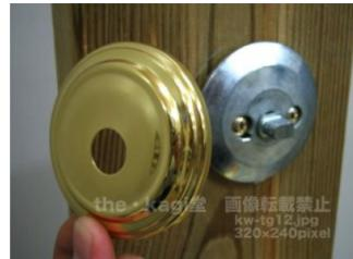
11.次にビス2本がありますのでこのビスをプラスドライバーで取り外します。この際外側のシリンダーが落下しないように手で押さえながら作業して下さい。
