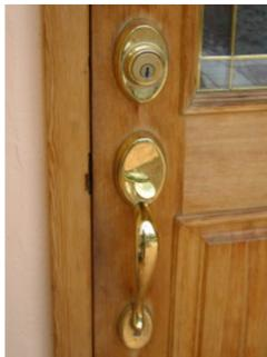
2.TITAN(タイタン)と外觀は一緒ですがシリンダーの取替方が違います。下記画像の様にシリンダー部分とドア側面のフロント部分に【kwikset】と刻印されています。
