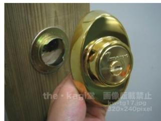
16.シリンダーを取り付ける際にシリンダーを外した中心を覗いてみればわかりますが、この穴に合うようにシリンダーのテールを合わせながらシリンダーを差し込みます。
