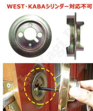
9. 飾り座を取払うとさらに補強プレートが現れます。図のような旧型プレートが使用されている場合は補強プレートを外して下さい。
