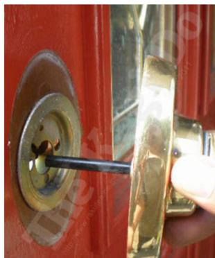
8. 次に室外側のシリンダーを取外します。飾り座がドアと密着して取れない場合は、布を巻いたハンマーやゴムハンマーなどで軽く叩いて外します。
