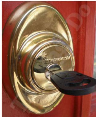
14. 実際にキーで動作確認をします。スムーズに施錠・開錠できたら取替完了です。作業時間の目安は10-15分程度です。
