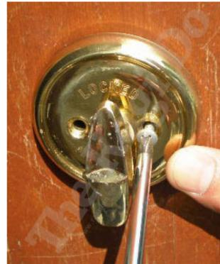
3. まずは、室内側サムターン部を取外します。ツマミが付いたカバーに見える2ヶ所の固定ネジをプラスドライバーで外します。
