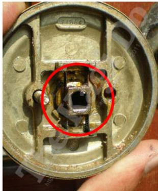
13. 室内側サムターンの取付け時にも同様にテールの向きに注意しましょう。しっかりとめ込みで外した固定ネジで締めます。
