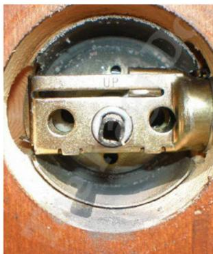
7. 図は、補強プレートを外した室内側の状態です。ドア内部のロックケースと、シリンダーのテール部が確認できます。
