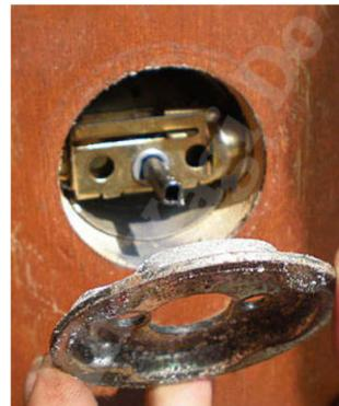
6. 固定ネジと補強プレートが外れます。室外側のシリンダーや飾り座などの部品が落ちないようにご注意下さい。
