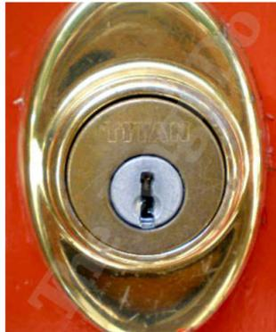
2. 既存のシリンダーは、図のように上部に「TITAN」と刻印されています。このシリンダー部分を交換していきます。
