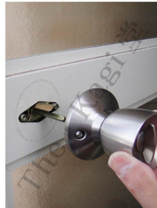
6. 室内ノブが外れます。 ※室外側のノブが落下しないように支えながら引き抜きましょう。
