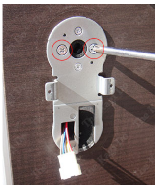
13. 赤丸部分のシリンダーの2か所の固定ネジをプラスドライバーで外します。赤丸部分のネジはそのまま大丈夫です。
