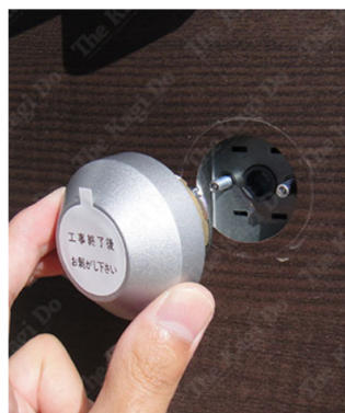
15. 新しいものに入替え、外す時とは逆の【手順10】～【手順4】で付直します。最後にシリンダーの封印シールを外し、付属純正キーで動作確認し完了です。
