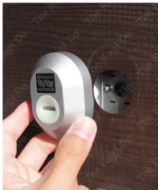
11. 上部シリンダーが外れます。新しいものに入替え、外す時とは逆の【手順10】～【手順4】で付直します。
