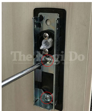
7. 次に室外ハンドルを引抜きます。図は室内ハンドルを外した上部です。ネジ山が大きいので、必ずこの固定ネジ(赤丸部分)をプラスドライバーで外して下さい。
