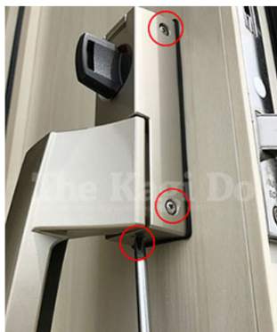
4. まずは、室内ハンドルを外します。上部ハンドル側面にある上下3ヶ所の固定ネジ(赤丸部分)をプラスドライバーで外します。
