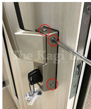
5. 下部ハンドルも同様に上下3ヶ所の固定ネジ(赤丸部分)をプラスドライバーで外します。ハンドルが落ちないように注意して下さい。
