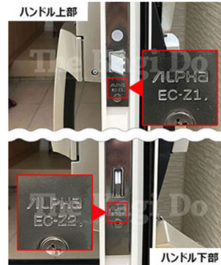
3. 開いたドア側面にある、カンヌキが入りするフロントプレートの錠前刻印を確認します。図では「ALPHA EC-Z1+EC-Z2」の刻印があります。
