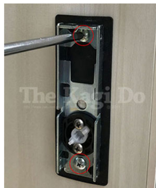
8. 室内ハンドルを外した下部も同様に、ネジ山が大きい上下2ヶ所の固定ネジ(赤丸部分)をプラスドライバーで外して下さい。
