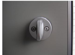
6.サムターンの2本のネジをプラスドライバーで緩めます。
