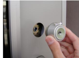
9.次に下部サムターンを見てみましょう。下部サムターンは脱着サムターンになっている場合が多く、画像のようにサムターンのつまみ部分は白いボタンを押しながら抜き取れます。つまみ部分が付いた状態ですとシリンダーを取り外せませんので取り外して下さい。
