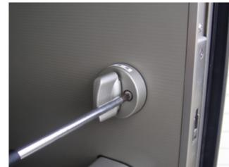
7.ネジを緩め、取り外せばサムターンが取り外せます。この際サムターンを取り外すと同時に外側シリンダーも外れますので手でシリンダーを押さえながら作業をして下さい。
